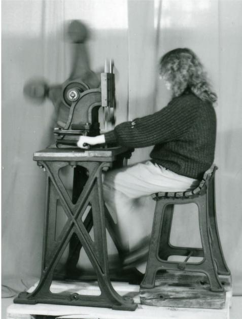
Mit ihr haben Frauen den Firmennamen „Douglas“ in Seifen gepresst. Die Maschine hat keinen Motor. Sie wird durch Druck auf das Tritt Brett mit den Füßen angetrieben. Dabei dürfen die Hände die Maschine nicht loslassen.
